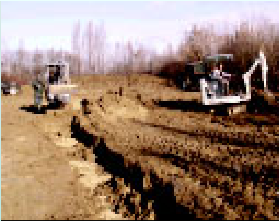
La zona centrale dell'appezzamento a bosco: durante l'intervento di trasformazione in area umida (gennaio 2007)
