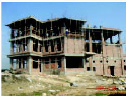
Veduta della nuova scuola professionale in costruzione
