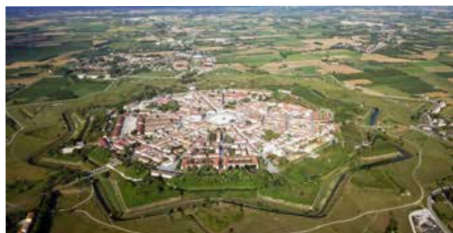
Una vista aerea di Palmanova (cortesia Comune di Palmanova)
