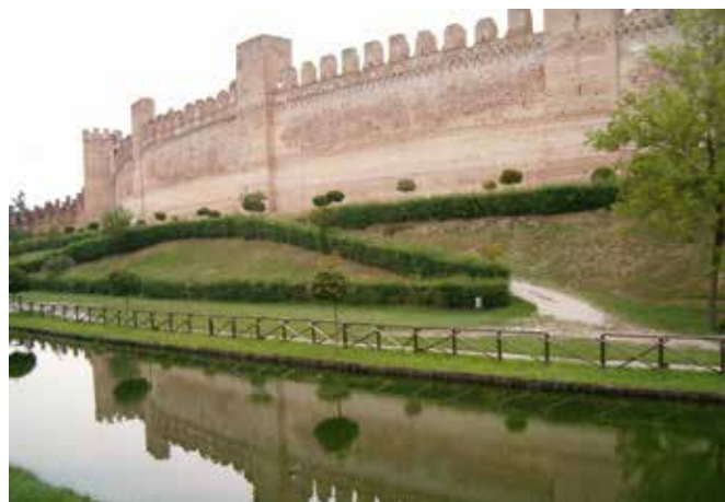
Il fossato e le imponenti mura che proteggono Cittadella
