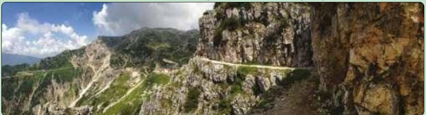
Panoramica della Strada delle 52 Gallerie (gentile concessione Paolo Asnicar guida alpina)
