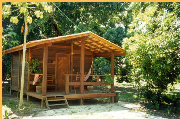
L'esterno di uno chalet in legno dell'Hotel Fazenda Santa Rita
